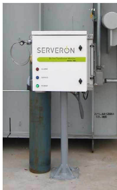
图 5 监测仪支架安装
