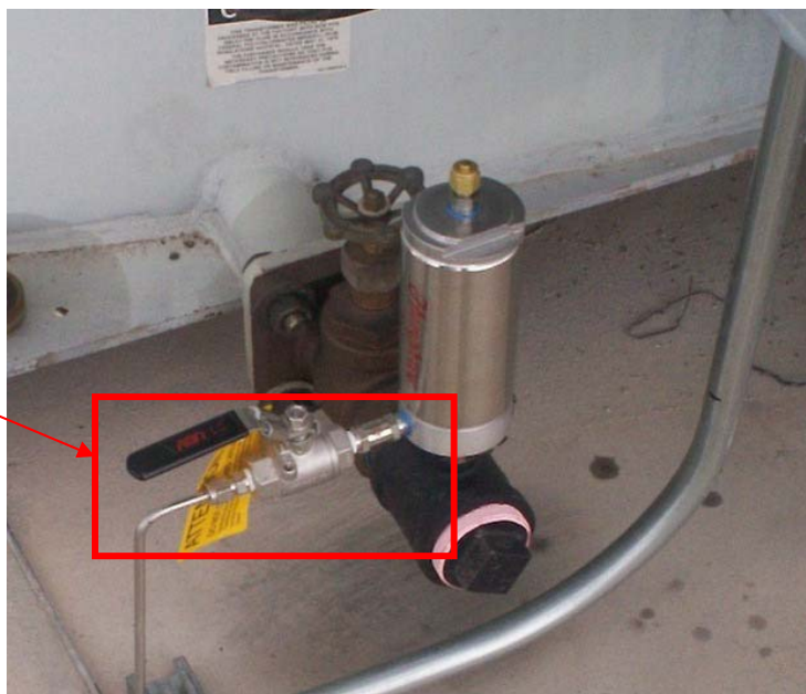
图 4 安装放气装置
